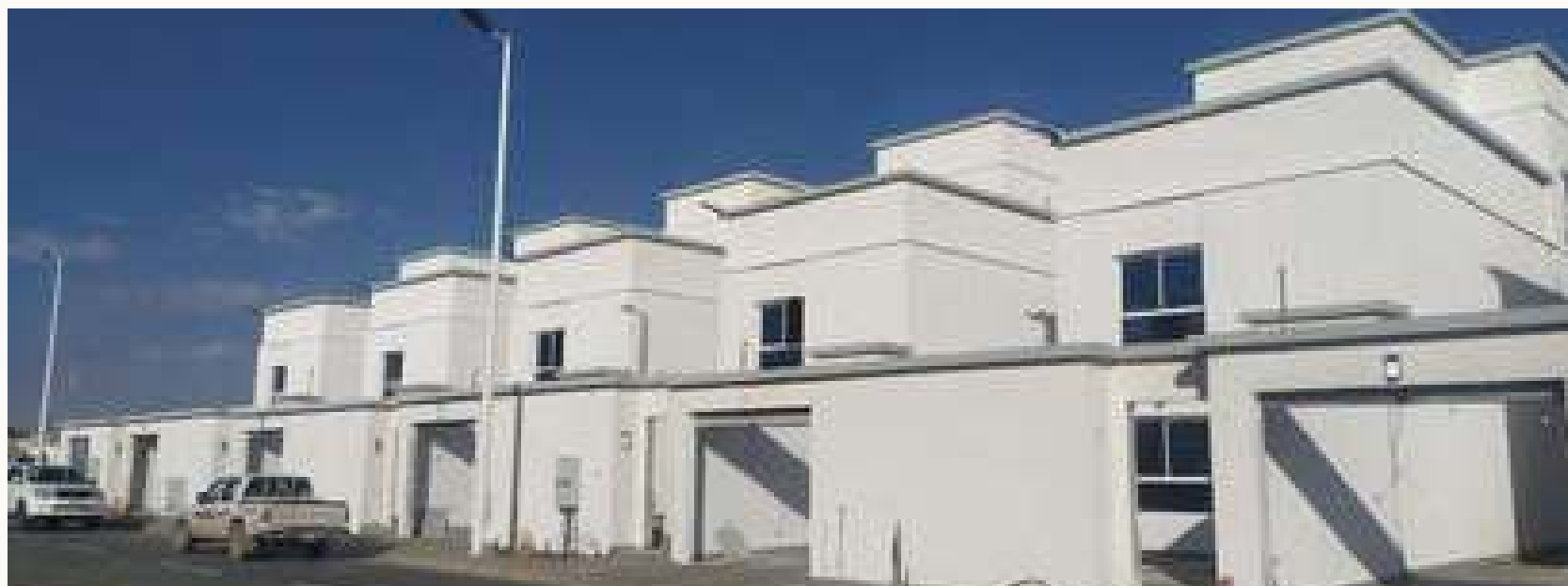
AL TAIF PROJECT
